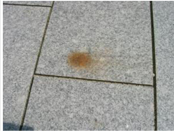
rostiger Splitt im Unterbau
