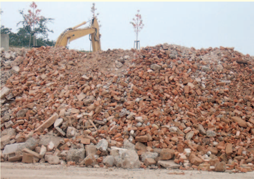
Abb. 6: INPUTHALDE AUS ZIEGELREICHEM BAUSCHUTTMATERIAL
