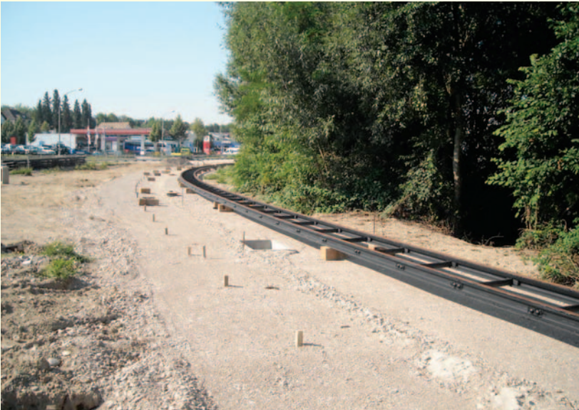
Abb. 7: STRASSEN-/STADTBAHNBAUSTELLE „STADTBAHNVERLÄNGERUNG ZÄHRINGEN“
