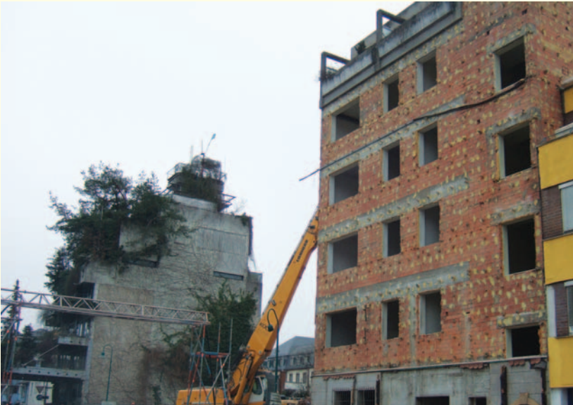
Abb. 1: SELEKTIVER RÜCKBAU EINES GEBÄUDES NACH ENTKERNUNG
