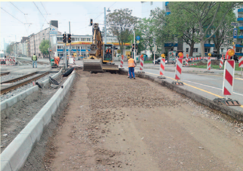
Abb. 8: STRASSENBAUSTELLE IM ZWEITEN BAUABSCHNITT „SÜDTANGENTE“
